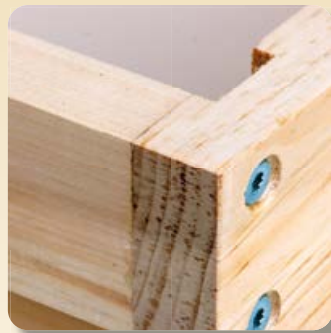
Standard-Eckverbindung der Beuten
